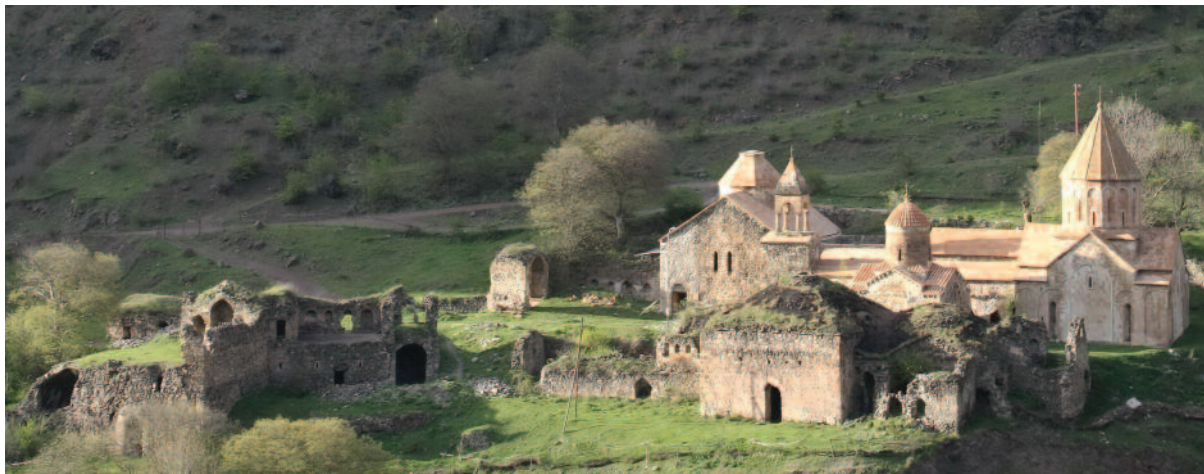
Илл. 1. Вид монастырского комплекса Дадиванк с юга (фото С. Айвазяна, 2010 г.)
