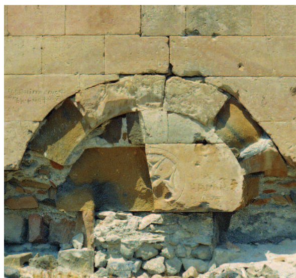
Тимпан и притолока северного (фото епископа С. Чудджяна, 2011 г.) и южного (фото С. Карапетяна, 2000 г.) входов Мренского собора
