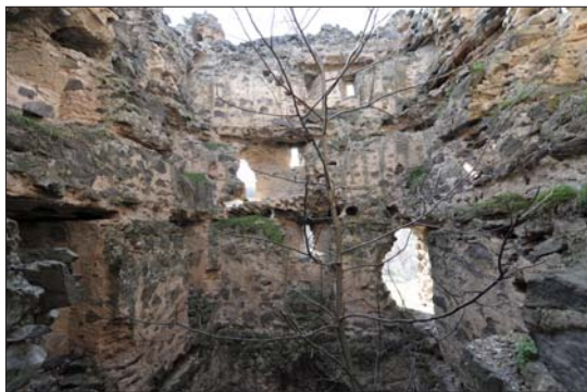
Հատվածներ բերդ-աշտարակից Partial views of the fortified tower
