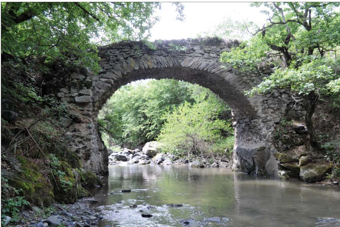
Ոսկեպարի հին կամրջի հոսքընդդիմ և հոսքընթաց ճակատները The facades of the old bridge of Voskepar looking up-stream and downstream respectively
