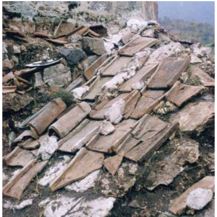
ԴԱԴԻ ՎԱՆՔ. գմբեթավոր փոքր եկեղեցին հյուսիս-արևմուտքից, հյուսիս-արևելքից, գմբեթը ներքուստ (լուս.՝ Ս. Կարապետյանի, 1993 թ.) և լամբերի մաքրումից հետո ի հայտ եկած հնամենի կղմինդրածածկը (լուս.՝ Ս. Այվազյանի, 1998 թ.)
